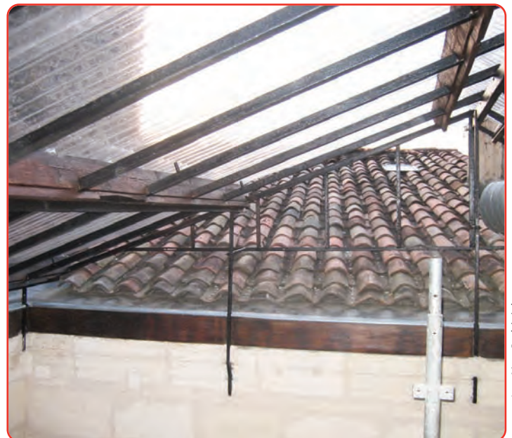
Toit en onduline au-dessus du puits de jour.
