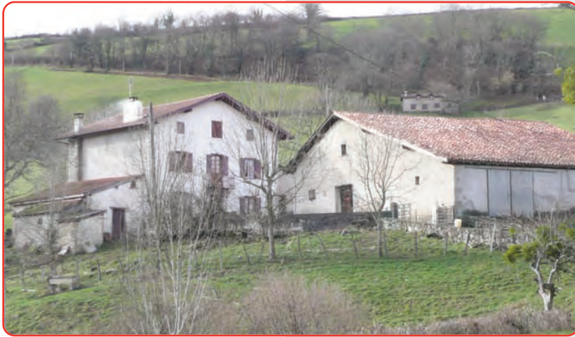
La maison Errekulisenia située au quartier Huntto du village de Saint-Michel. Errekulisenia etxea Huntto asoan Eiheralarre herrian.
