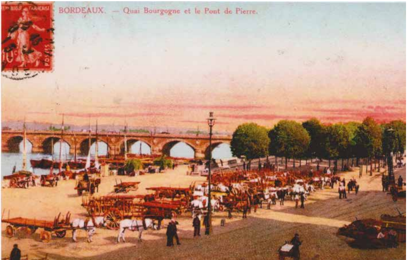
Le Pont de pierre vu du quai Richelieu / Richelieu kaitik ikusitako harrizko zubia
